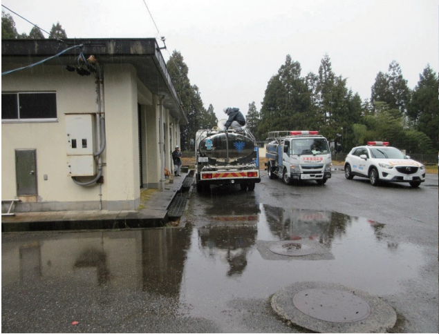
穴水町:宇留地浄水場
