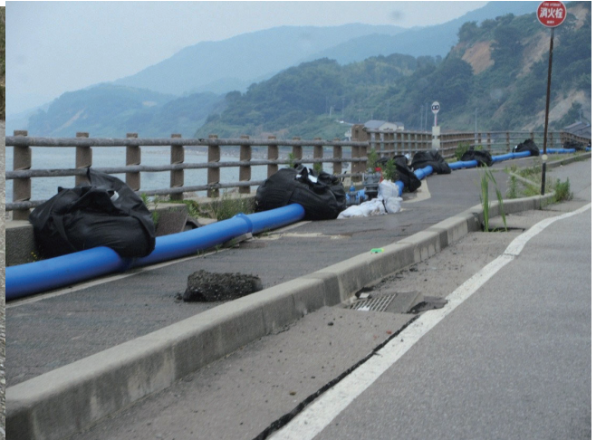
輪島市市街地から延びる仮設配水管
