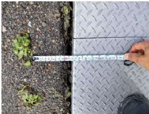
免震パネル隣の草の移動 から12cm程度変位と推定
