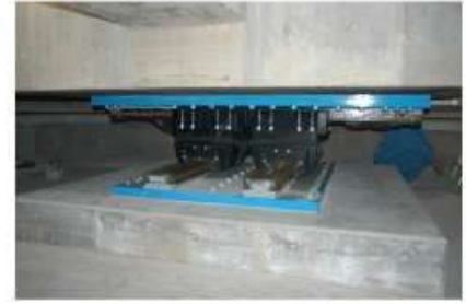
免震支承(アイソレータ:建物を支えて、地震時にゆっくりと揺らす装置)の例
