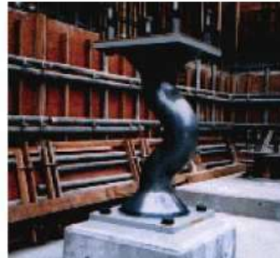
減衰装置(ダンパー:揺れのエネルギーを吸収する装置)の例
