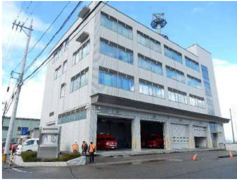
建物全景(RC造, 2006年竣工) 建物・室内被害無し、活動継続
