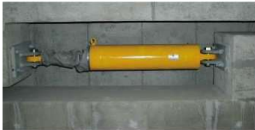
減衰装置(ダンパー:揺れのエネルギーを吸収する装置)の例
