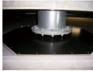
免震支承(アイソレータ:建物を支えて、地震時にゆっくりと揺らす装置)の例
