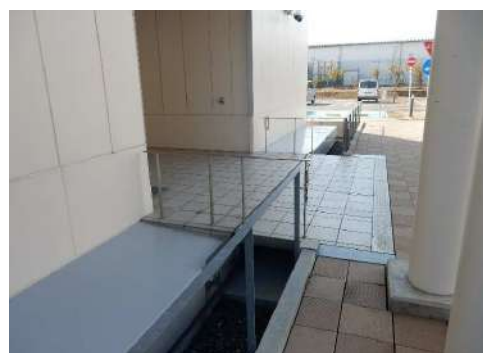
免震クリアランスと出入り口の免震Exp.J(明快な設計)
