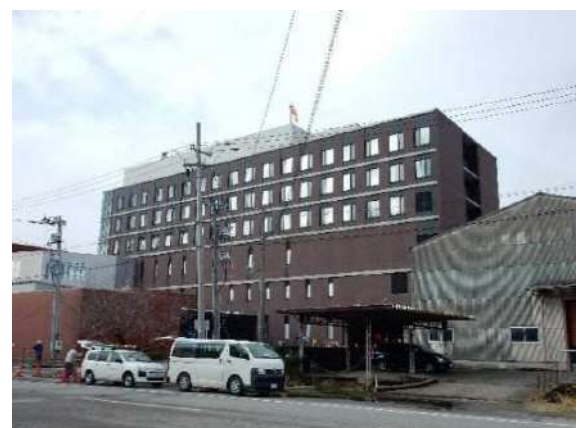
免震棟本館(2013年竣工: 7階RC造)
