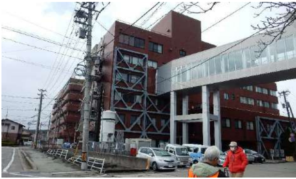
3病棟(耐震補強済): 機器・室内被害で医療継続困難、全患者を免震棟に移動
