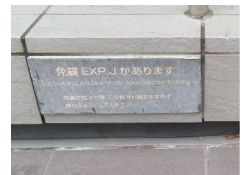
免震であることの掲示(免震Exp.Jの設置例) 6
