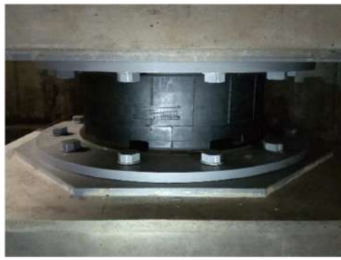
天然ゴム系積層ゴム支承 (損傷・変状なし)
