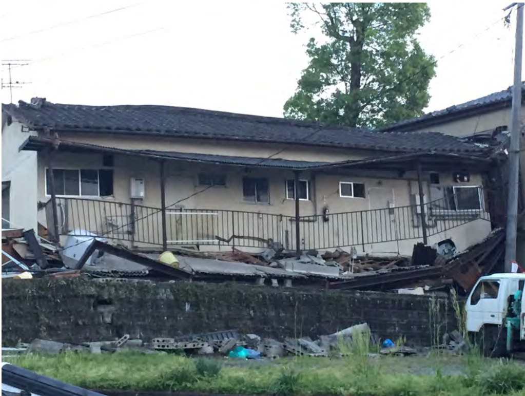
1階が完全に破壊した2階建て木造アパート建築 (4月14日21:26分に起きた熊本地震で震度7の揺れを受けた益城町)
