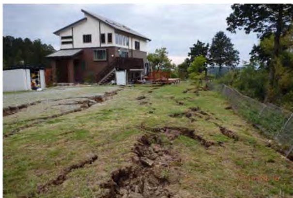
宅造盛土の崩壊（清田隆氏提供）
